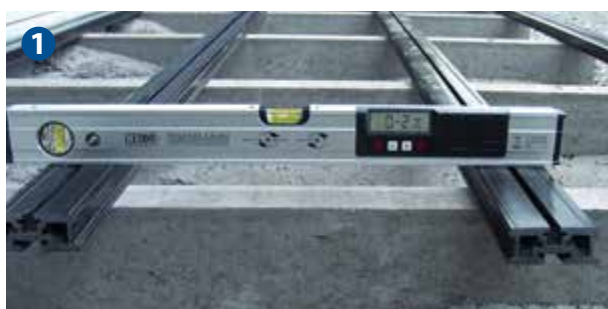
Préparer le sol et fixer le support.
