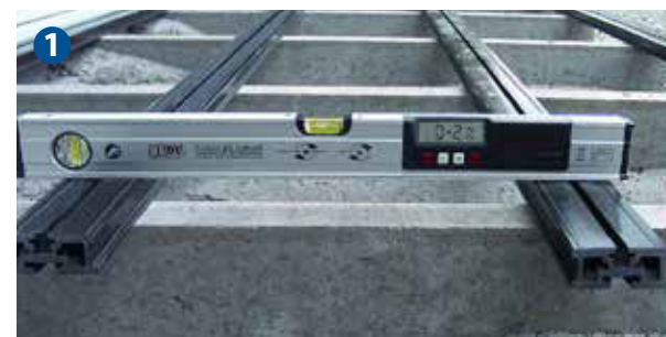
Voorbereiding van de ondergrond en bevestiging van de onderbalken.
